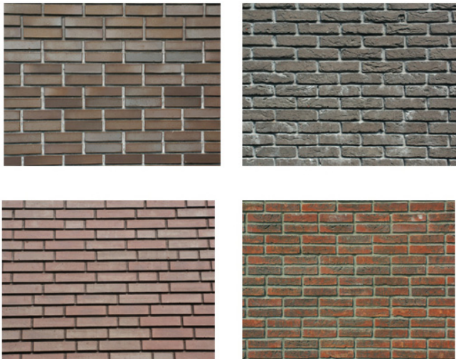
NATUURLIJKE UITSTRALING METSELWERK
