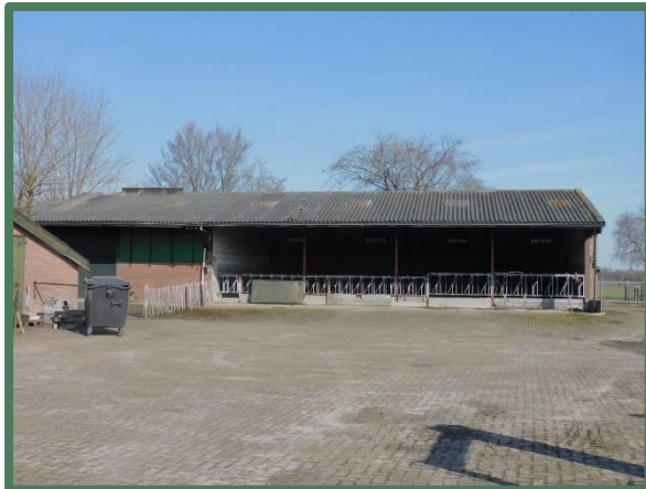
Te slopen jongveeststal
