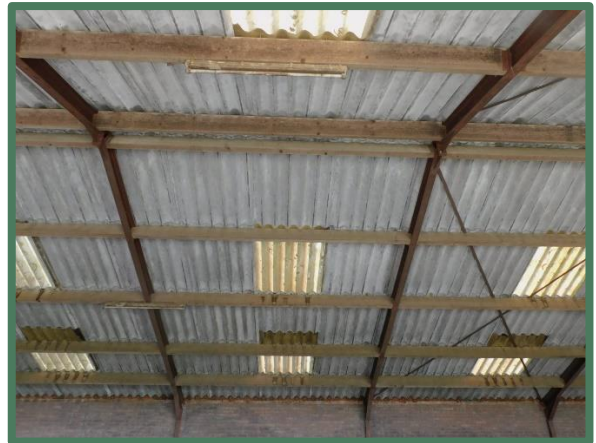
Overzicht onderzijde dak te slopen ligboxstal
