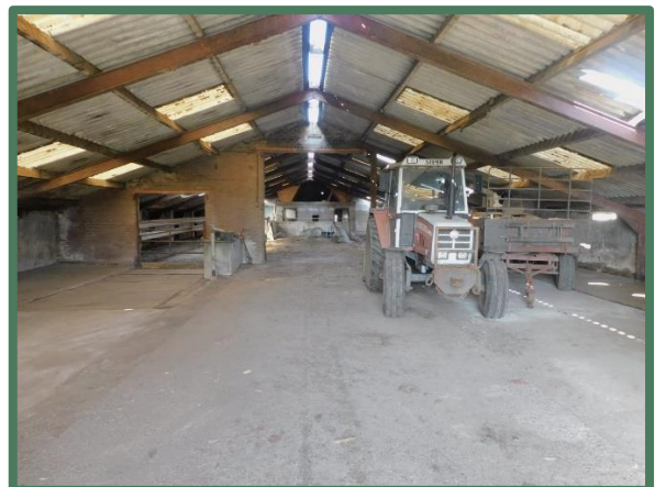
Binnenzijde te slopen ligboxstal
