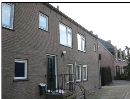
Zijkant grotere gebouw (ingang woonhuis)
