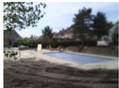
Geplande bouwlocatie bijgebouw naast zwembad
