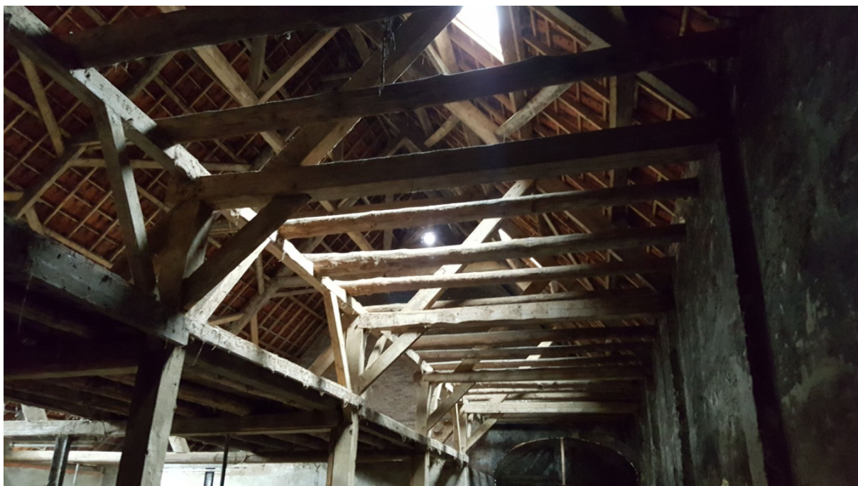
Binnenzijde Stenen Schuur. Foto: B. Verhoeven | Ecoresult B.V.
