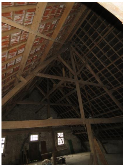
afb. 57 – interieur, bedrijfsgedeelte, kapconstructie
