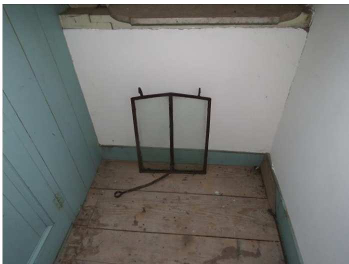
afb. 34 – interieur, zolder, oud klepraam van vervangen dakramen
