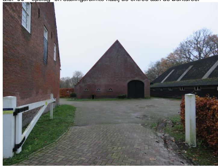
afb. 91 – erf aan de zijde van de Roosendaalsebaan
