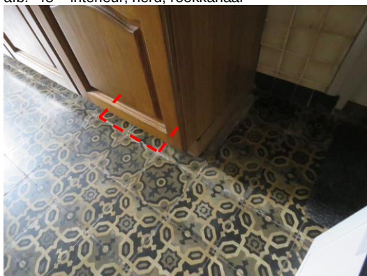
afb. 49 – interieur, herd, aftekening rechter wang schouw in keuken tegen de westwand
