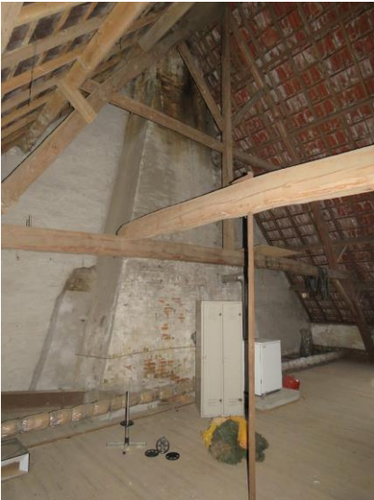
afb. 55 – interieur, bedrijfsgedeelte, rookkanaal
