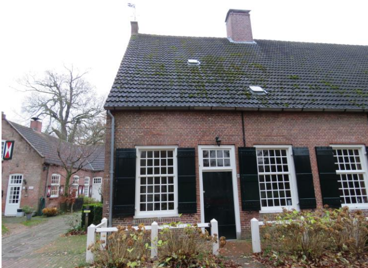
afb. 26 – voorgevel, linker deel
