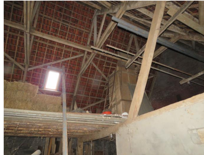
afb. 78 – intern, zicht in de kap vanuit de oostzijde
