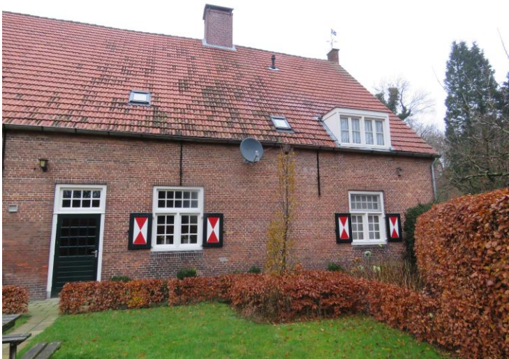
afb. 30 –rechter gedeelte achtergevel
