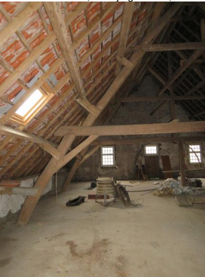
afb. 56 – interieur, bedrijfsgedeelte, kapconstructie
