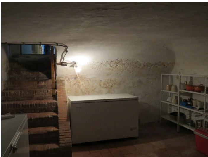
afb. 37 – interieur, kelder gezien naar het westen
