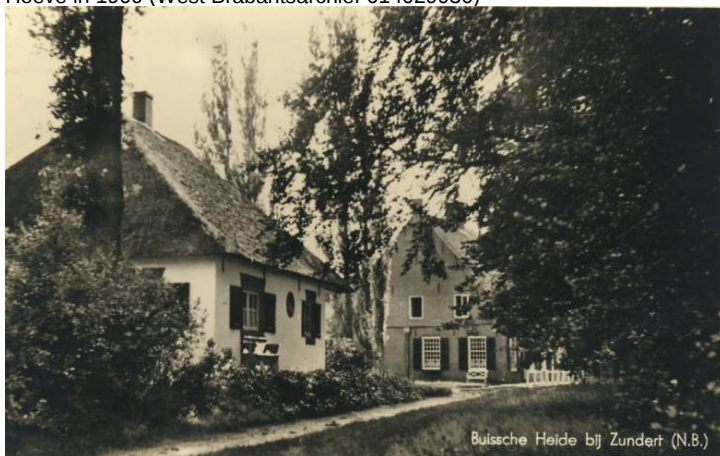
afb. 21 - Angora en Buisse Hoeve gezien over de oude Roosendaalsebaan vanuit het oosten nadat de Roosendaalsebaan is verlegd
