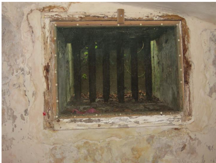
afb. 36 – interieur, kelderlicht met smeedijzeren diefijzers
