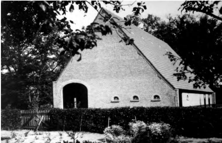
afb. 64 – zuidgevel schuur kort na de bouw in 1941 (bron: BBA, pag. 86)
