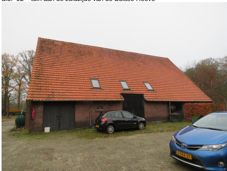
afb. 93 – erf oostelijk van de stenen schuur
