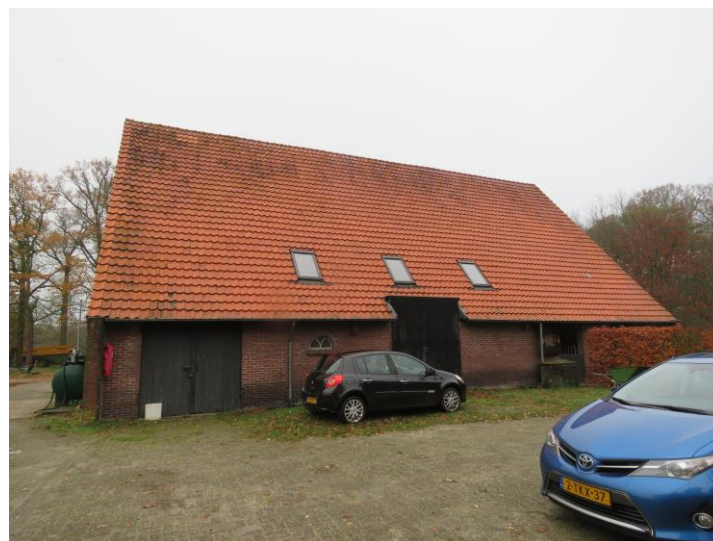
afb. 75 – oostgevel (zuidelijk deel)
