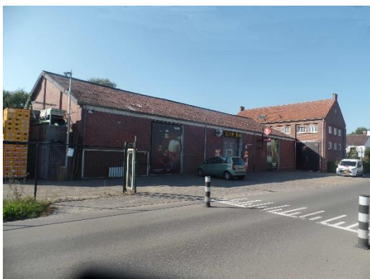
De aangebouwde loods
