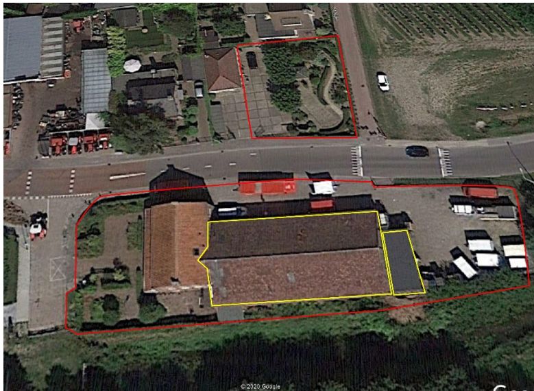
Fig.2 Het plangebied is rood omlijnd. De bebouwing die afgebroken wordt is geel omlijnd.
