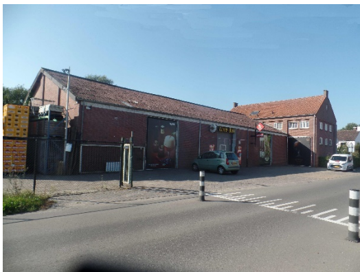
De aangebouwde loods
