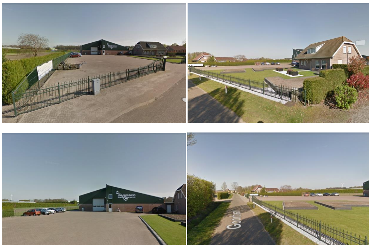
Figuur 6: Foto's van bestaande situatie Goorbaan 1a
