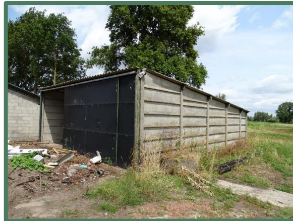
Overzicht te slopen schuur
