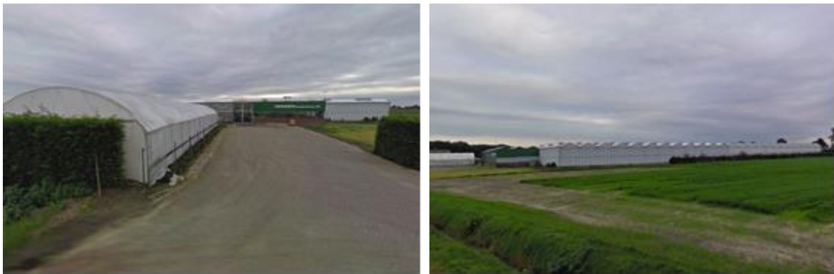
Figuur 5: Foto's Minnelingsebrugstraat 21
