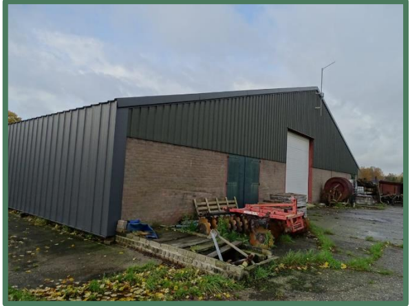
Binnenzijde te behouden loods
