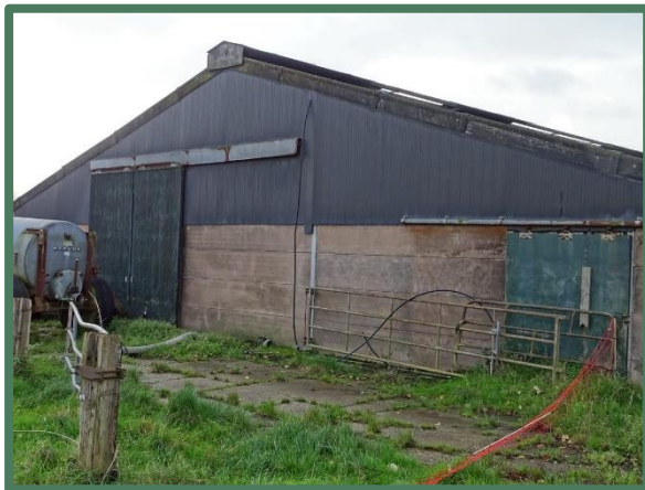
Overzicht te slopen melkveestal
