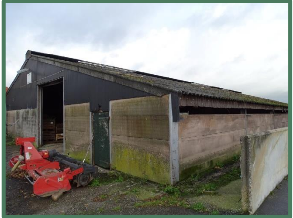
Binnenzijde te behouden loods
