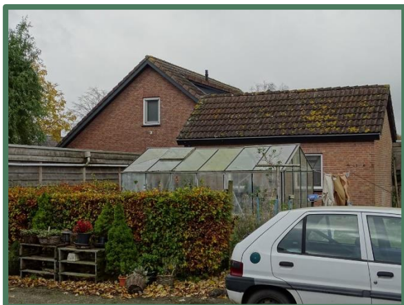
Overzicht woning en bijgebouw
