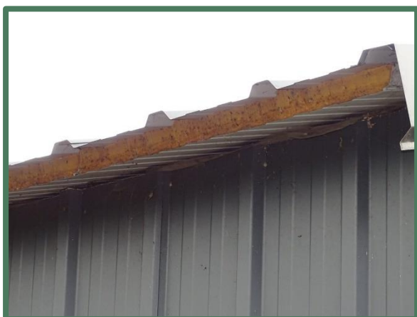
Sandwichpanelen daken zonder ruimte
