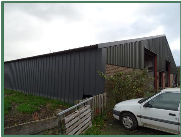
Overzicht te behouden loods
