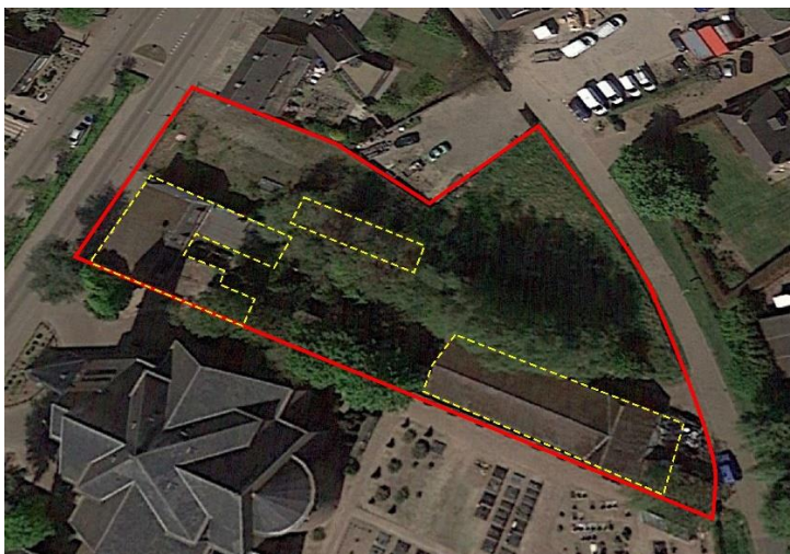
Fig.2. De bestaande situatie toen de begroeiing nog intact was. Het gehele plangebied is rood omkaderd. Met de gele stippellijnen zijn globaal de contouren aangegeven van de te slopen hoofdbebouwing.
