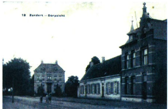
Het gebouw op de huidige Markt 25 anno 1910-1920, met reeds de huidige bebouwing ter plaatse van het Van Gogh huis.
