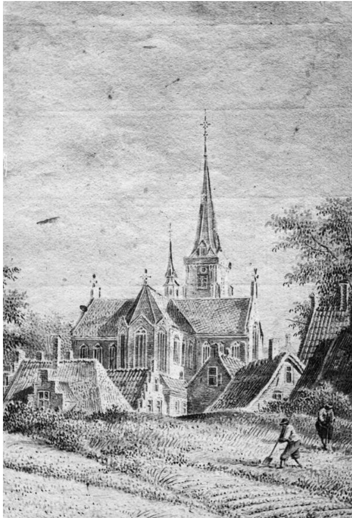
Afbeelding 10. Kerkgebouw voorafgaand aan de sloop in 1928 (bron: www.rijksmonumenten.nl ).
