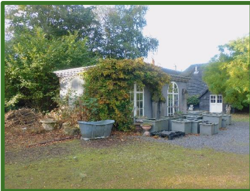
Te slopen bijgebouw
