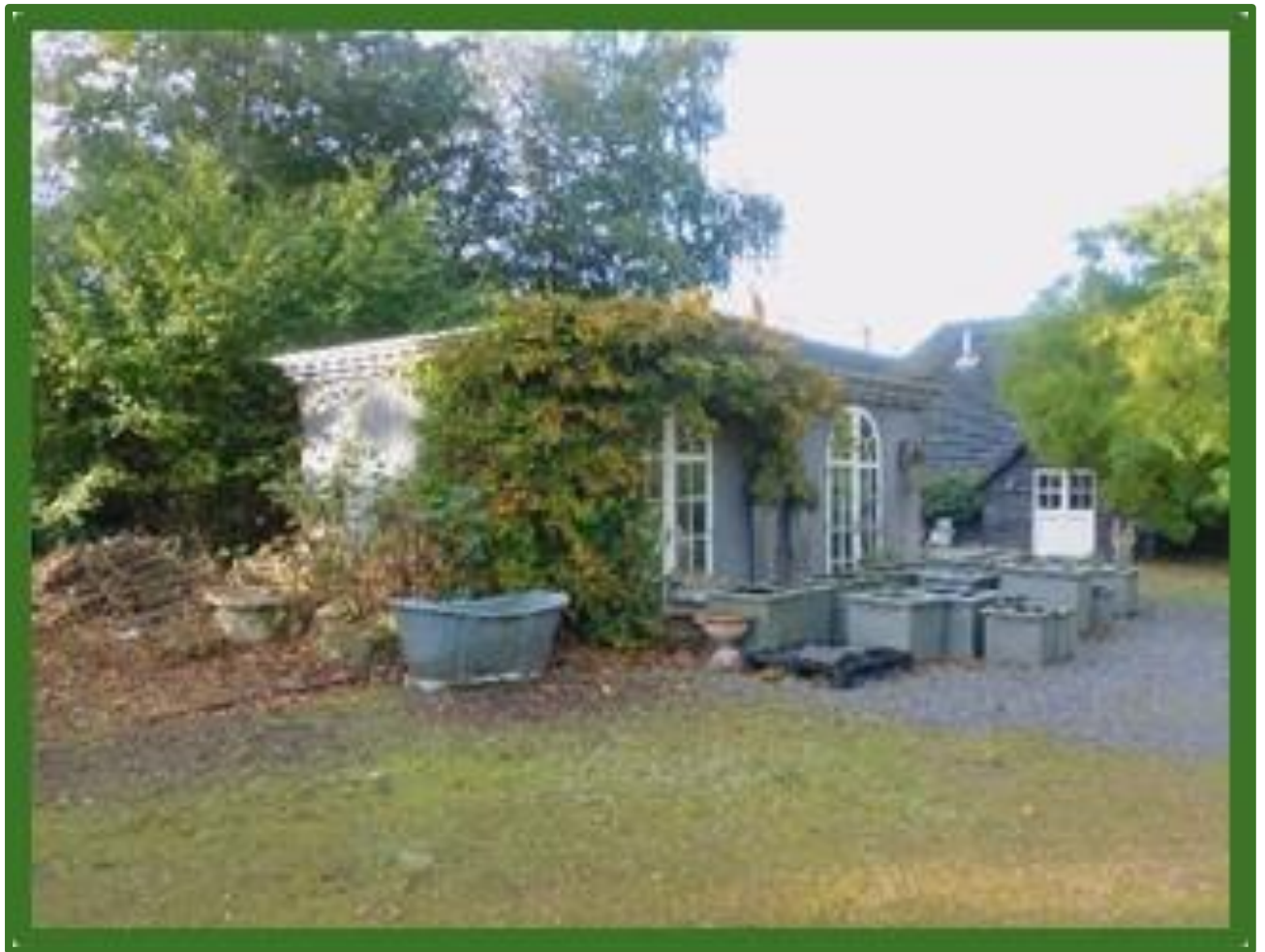
Te slopen bijgebouw
