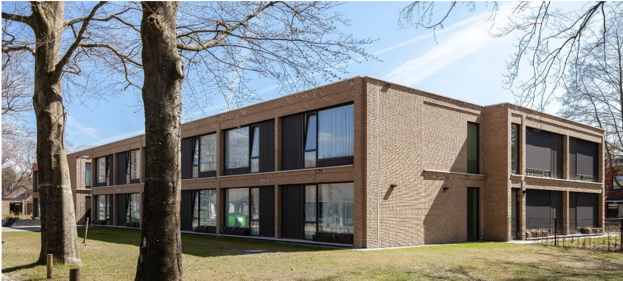
baksteen in natuurlijke tint en ingetogen detaillering
