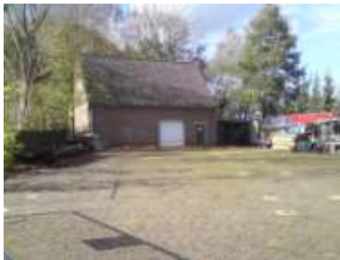
Voorterrein verhard met klinkers. Op de achtergrond een bestaande schuur. Op het buitenterrein vindt opslag plaats van corsobouwmaterialen.
