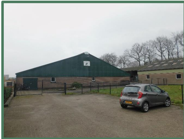
Te slopen bedrijfsgebouwen vanaf Breedschotsestraat
