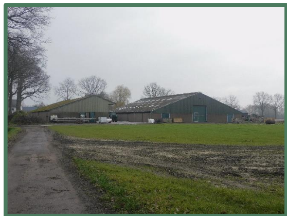
Overzicht bebouwing vanaf achterzijde
