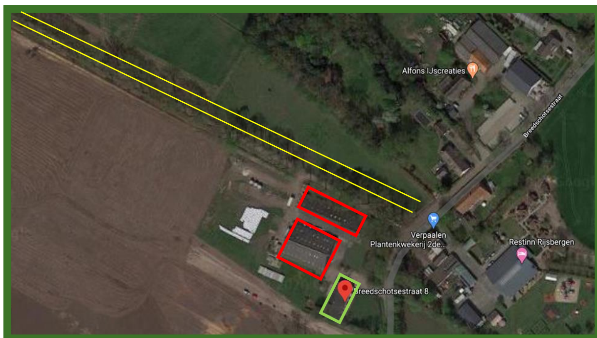
Te slopen bedrijfsgebouwen in rood, woonhuis in groen, bomenrij in geel. Bron: Google Earth.
