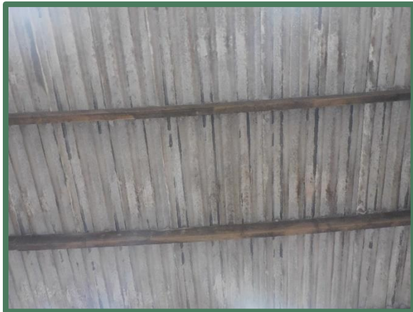
Onderzijde dak rundveestal
