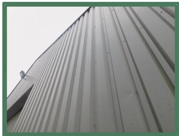
Afgesloten kopgevel van damwand
