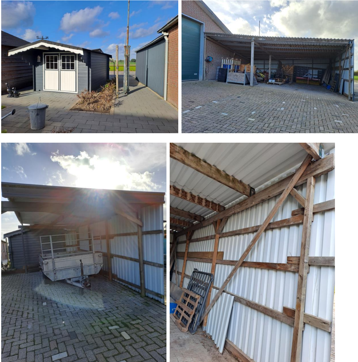
Figuur 18: Foto's te slopen bouwwerken planlocatie
