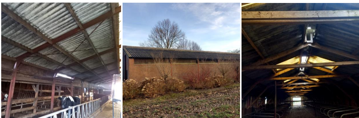
Figuur 15: Foto's aanwezige te slopen stallen
