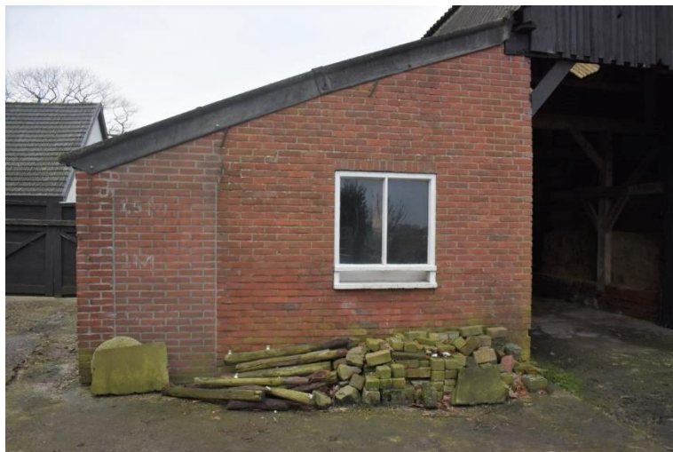
Achtergevel aanbouw aan rechterzijde (zuidoostrichting).
