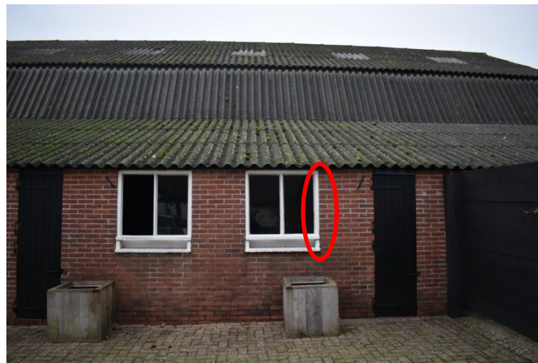
Twee betonnen tweeruits stalvensters met ventilatieopening met onregelmatig metselwerk (cirkel).
