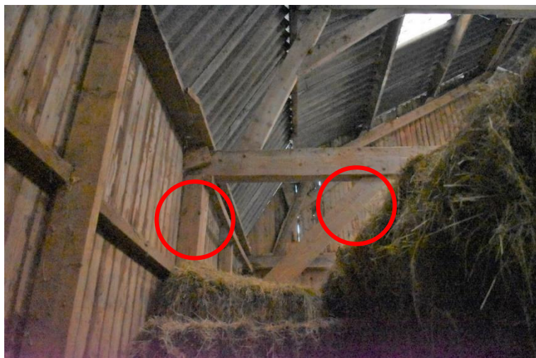
Telmerk VIIII (gebint 4 gezien vanaf de straatzijde).
