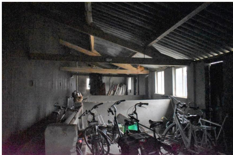
Aanbouw aan rechterzijde (zuidoostrichting), gezien richting achtergevel.
