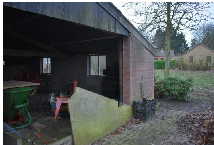
Achtergevel aanbouw aan rechterzijde (noordoostrichting).
