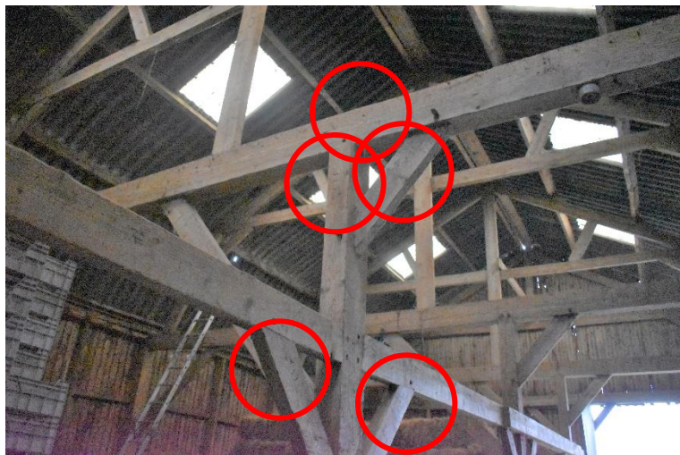
Telmerk XII en VII (gebint 2 gezien vanaf de straatzijde).
