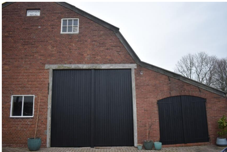
Voorgevel hoofdvolume met betonnen tweeruits stalvenster en dubbele houten loopdeur met aangesmeerd kader.
