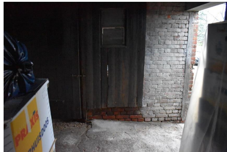
Gedeeltelijk gecementeerde linkerzijgevel van het hoofdvolume.
