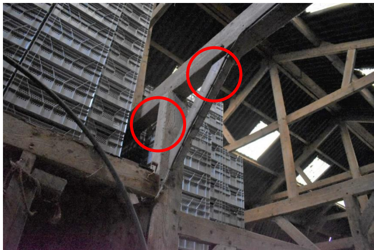
Telmerk IV (gebint 1 gezien vanaf de straatzijde).
