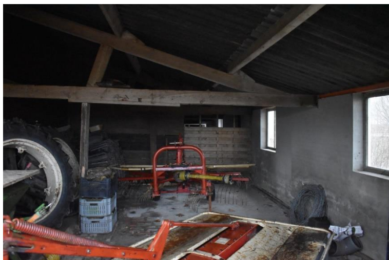
Aanbouw aan linkerzijde (noordoostrichting) gezien richting voorgevel.
