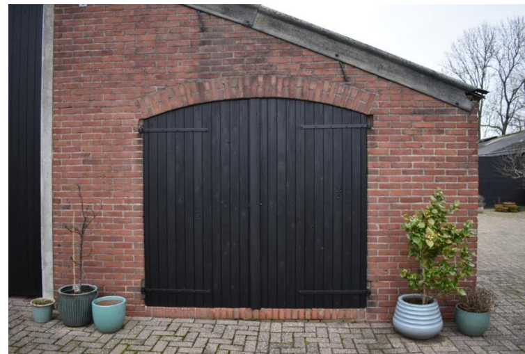
Voorgevel aanbouw aan rechterzijde (zuidoostrichting).
