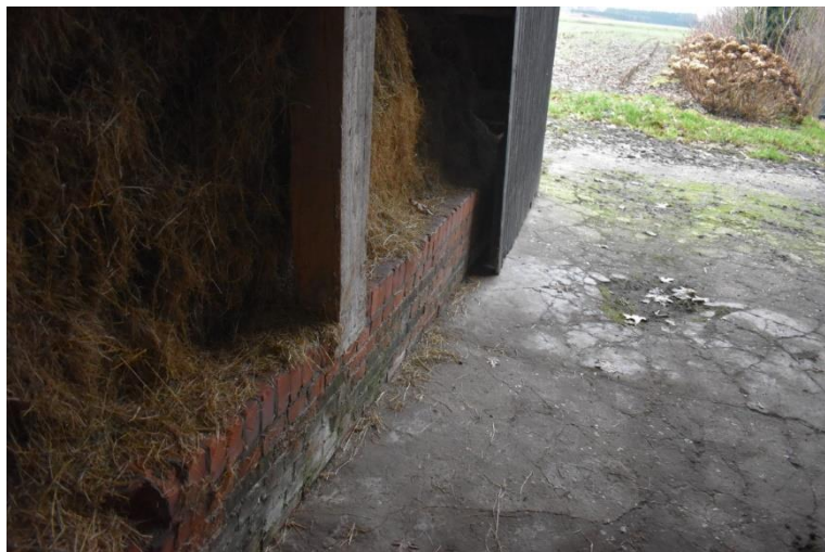
Gebint op de doorlopende met later aangebrachte betonnen vloer.
