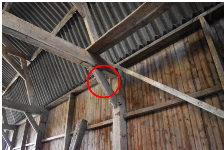
Telmerk IIV (gebint 2 gezien vanaf de straatzijde).
