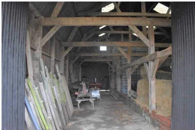
Het interieur gezien vanaf de achtergevel.
