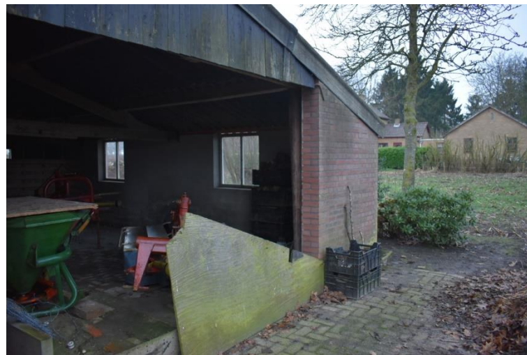
Achtergevel aanbouw aan rechterzijde (noordoostrichting).
