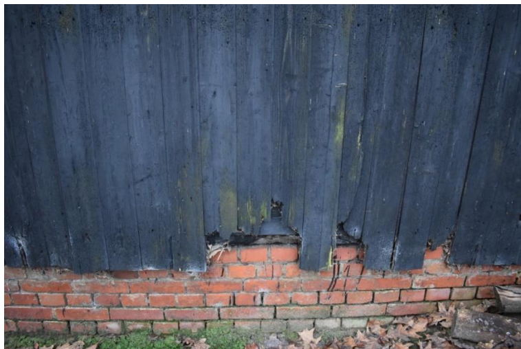
Bakstenen plint hoofdvolume.
