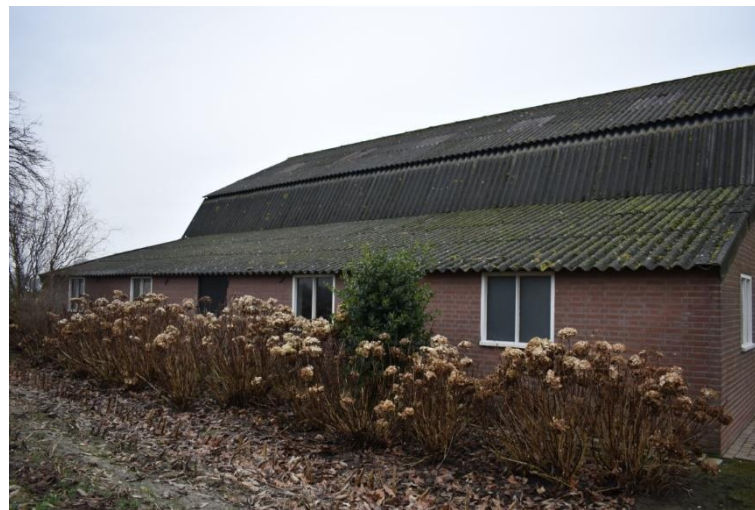
Rechterzijde van de linkerzijgevel.
