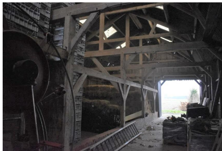
Het interieur gezien vanaf de voorgevel.
