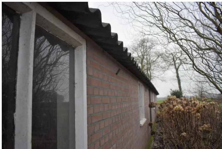
Linkerzijde van linkerzijgevel.
