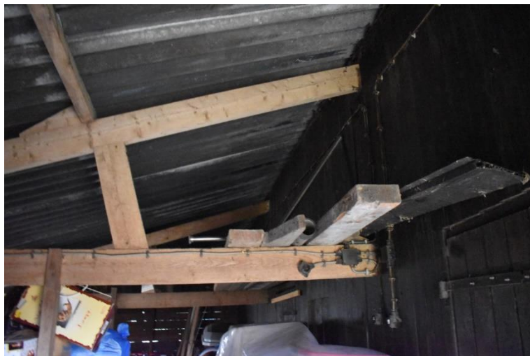
Aanbouw aan linkerzijde (noordoostrichting) gezien richting achtergevel.
