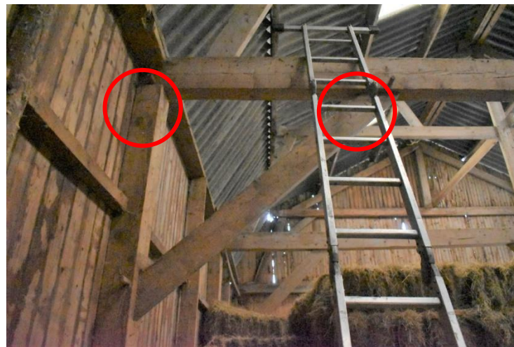
Telmerk VIII (gebint 3 gezien vanaf de straatzijde).
