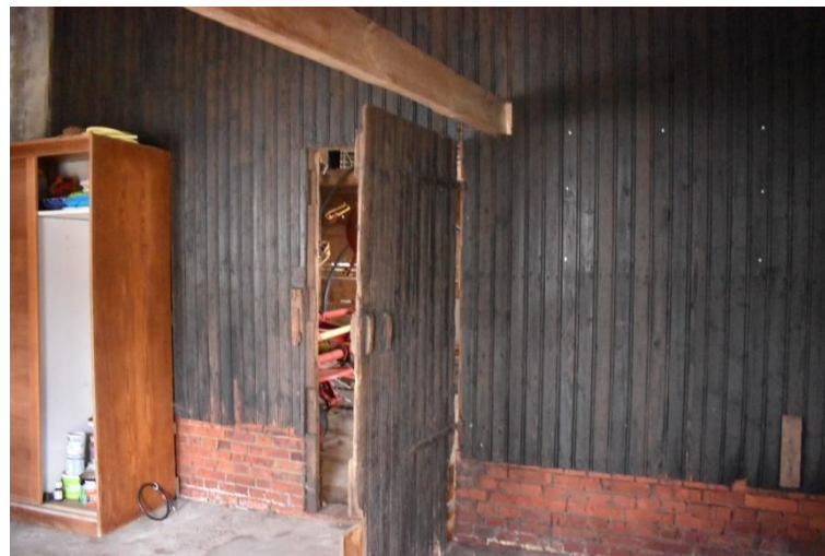
Rechterzijgevel van hoofdvolume vanuit aanbouw aan rechterzijde (zuidoostrichting).
