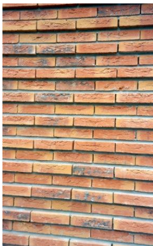
Horizontale geleding metselwerk met verspringing en wildverband
