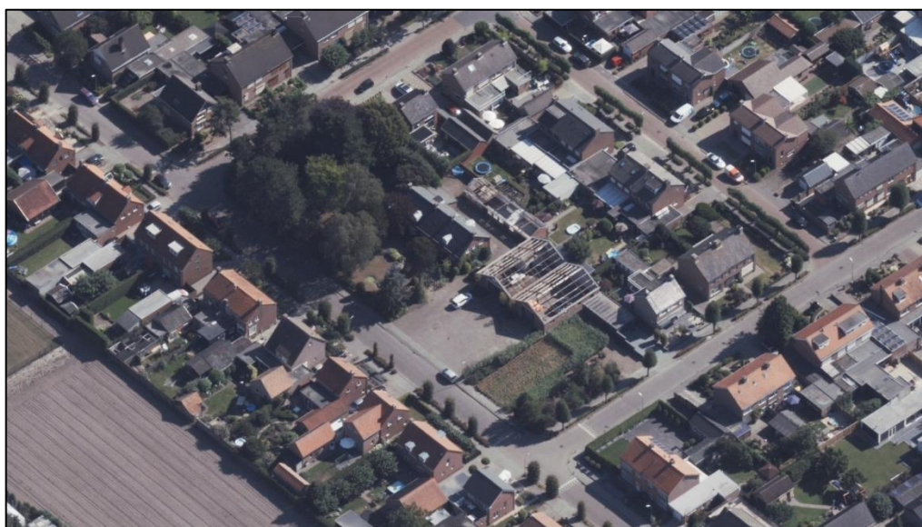
Overzichtsfoto plangebied vanuit noordelijke richting. Bron: Cyclomedia StreetSmart, 2020.
