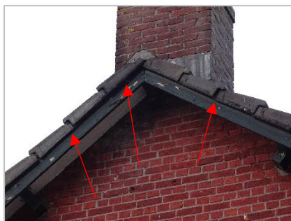
Foto 14: Impressie plangebied (openingen bij dakrand kopse kant woning).
