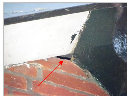
Foto 16: Impressie plangebied (openingen bij dakrand kopse kant woning).
