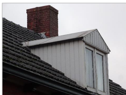
Foto 6: Impressie plangebied (dak en dakkapel woning).
