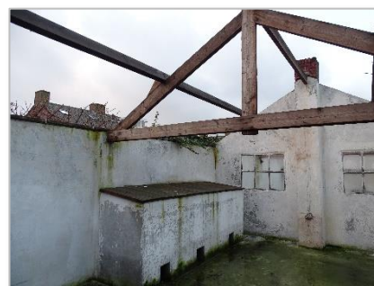
Foto 37: Impressie plangebied (voormalig bedrijfsgebouw – asbest dakbedekking reeds verwijderd).
