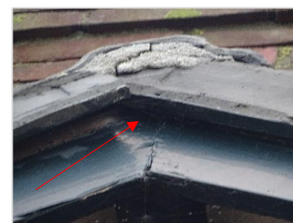
Foto 19: Impressie plangebied (openingen bij dakrand kopse kant woning).
