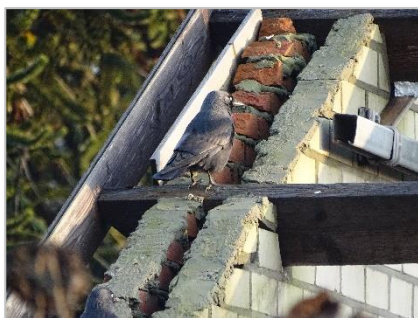
Foto 39: Impressie plangebied (voormalig bedrijfsgebouw – asbest dakbedekking reeds verwijderd).
