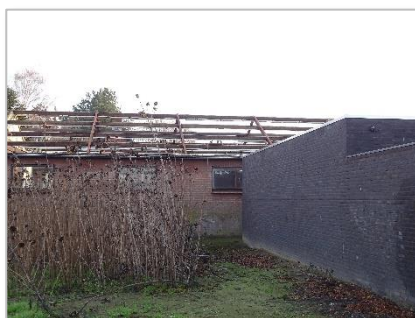
Foto 36: Impressie plangebied (voormalig bedrijfsgebouw – asbest dakbedekking reeds verwijderd).
