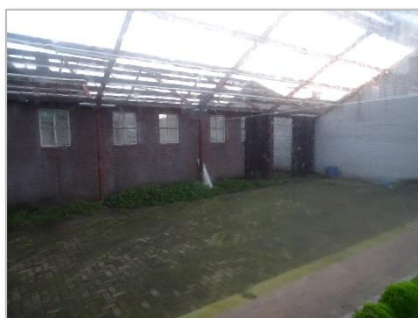
Foto 35: Impressie plangebied (voormalig bedrijfsgebouw – asbest dakbedekking reeds verwijderd).
