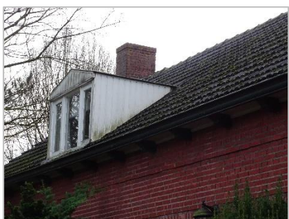
Foto 5: Impressie plangebied (dak en dakkapel woning).
