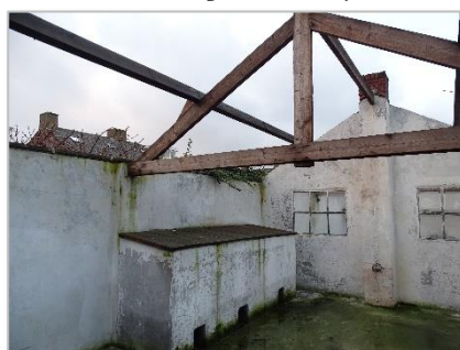
Foto 42: Impressie plangebied (voormalig bedrijfsgebouw – asbest dakbedekking reeds verwijderd).
