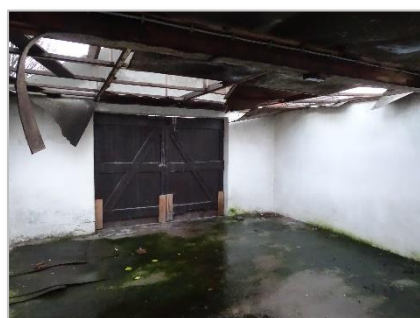
Foto 41: Impressie plangebied (voormalig bedrijfsgebouw – asbest dakbedekking reeds verwijderd).
