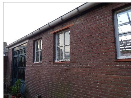
Foto 40: Impressie plangebied (voormalig bedrijfsgebouw – asbest dakbedekking reeds verwijderd).
