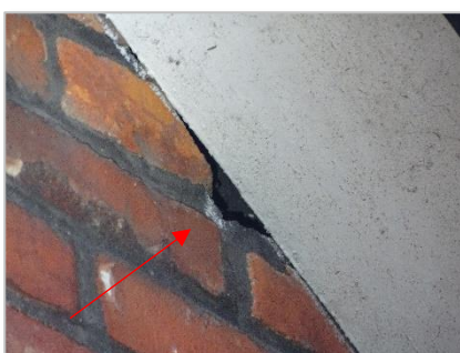
Foto 18: Impressie plangebied (openingen bij dakrand kopse kant woning).
