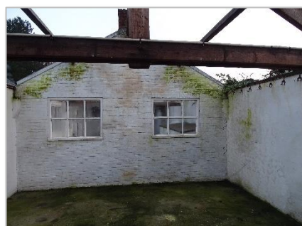
Foto 43: Impressie plangebied (voormalig bedrijfsgebouw – asbest dakbedekking reeds verwijderd).
