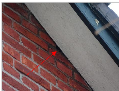
Foto 15: Impressie plangebied (openingen bij dakrand kopse kant woning).
