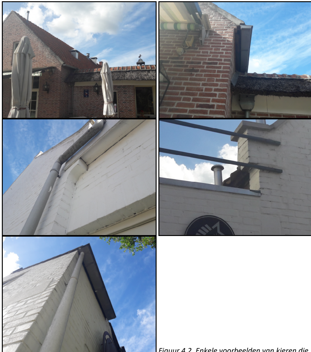
Figuur 4.2. Enkele voorbeelden van kieren die mogelijke geschikt zijn voor gierzwaluwen en vleermuizen
