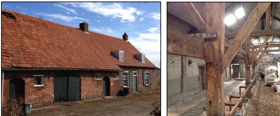
Afbeelding 8: Woonboerderij (gemeentelijk monument) en cultuurhistorische elementen in bedrijfsgebouw
