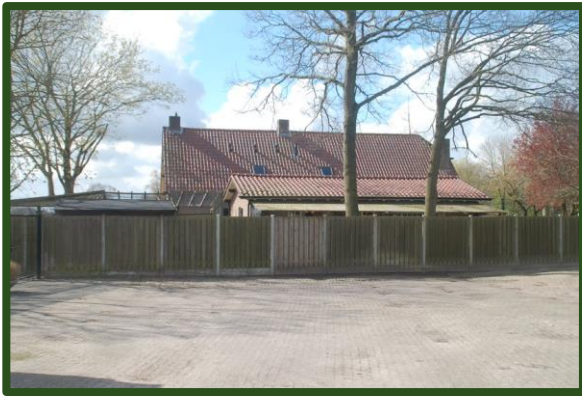
Woning achterzijde (vanaf het bedrijfsterrein)
