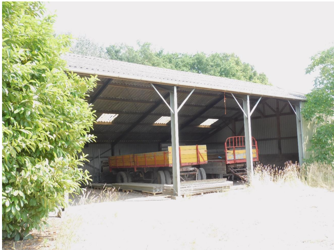
De op termijn te slopen loods
