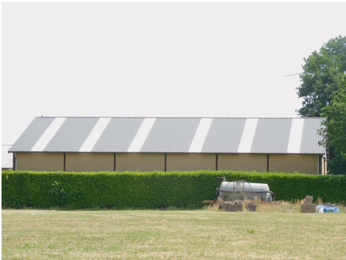
Zijgevel te slopen loods
