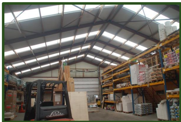
Binnenzijde te slopen loods
