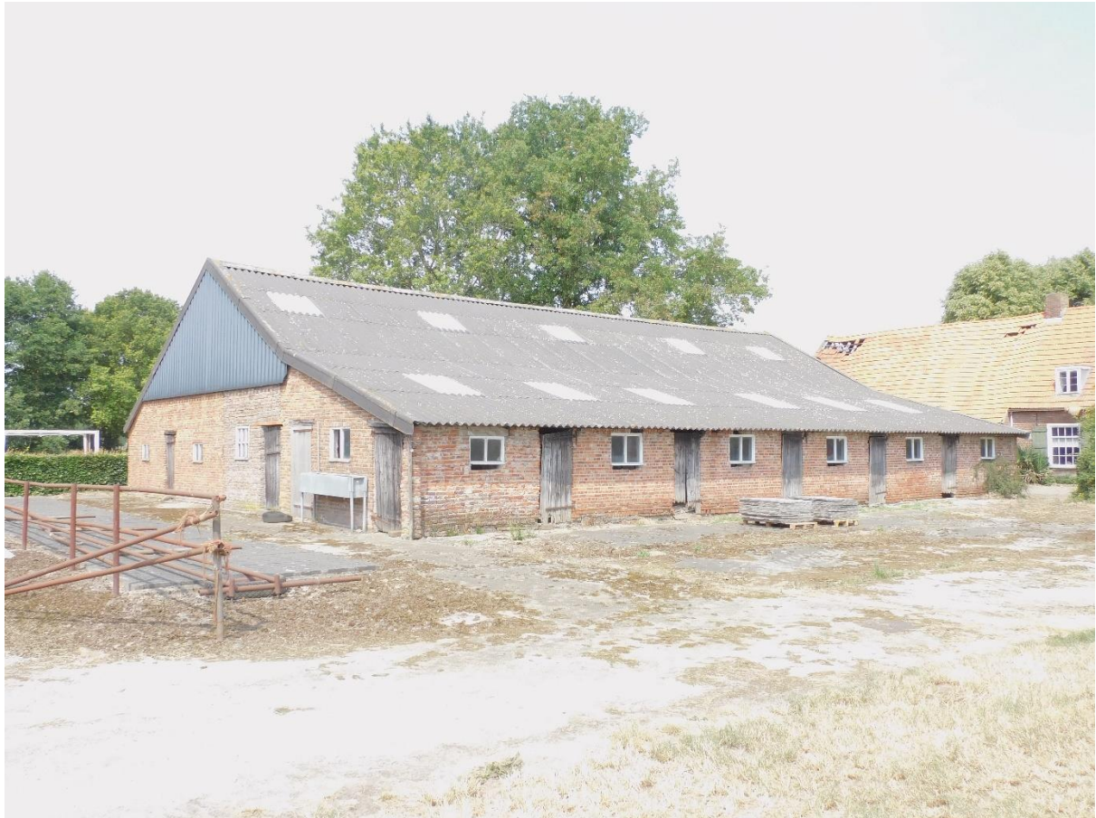
Te slopen voormalige rundveestal
