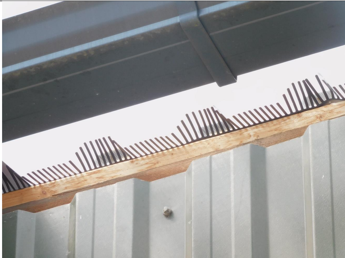
Detail vogelschroot te slopen loods
