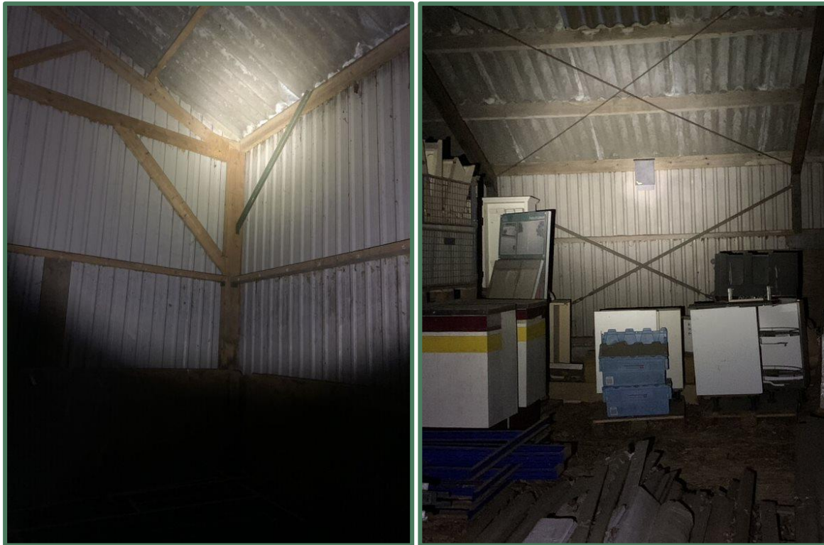
Verblijfplaatsen gewone dwergvleermuis in loods.
