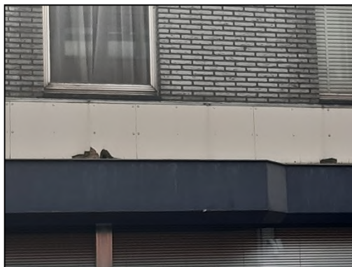
Figuur 4.3. Voorbeelden van mogelijke verblijfplaatsen voor vleermuizen in de bebouwing (foto: Molenstraat 25). Verblijfplaatsen kunnen bijvoorbeeld aanwezig zijn achter gaten en kieren in de betimmering.
