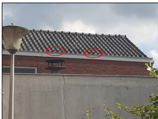
Figuur 4.2. Voorbeeld van mogelijke nestplaatsen voor gierwaluw en huismus in de bebouwing (foto: Molenstraat 25). Nestplaatsen kunnen bijvoorbeeld aanwezig zijn achter scheef liggende dakpannen (rood omcirkeld) of daklijsten.
