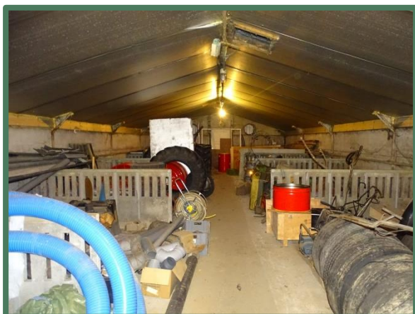
Binnenzijde te slopen varkensstal
