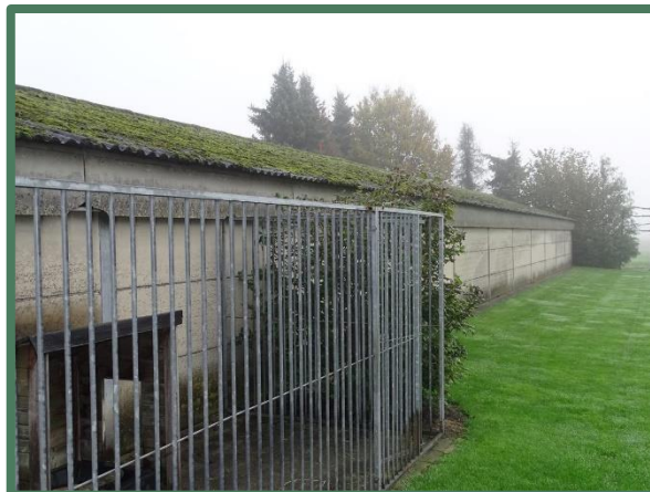
Overzicht kennel en dak te slopen varkensstal
