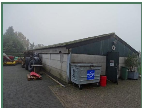
Overzicht te slopen varkensstal
