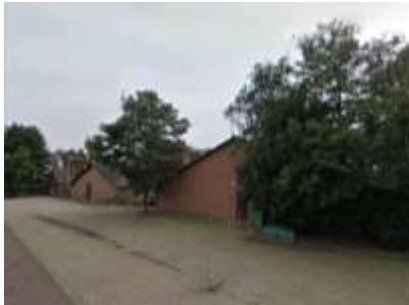
Straataanzicht in zuidwestelijke richting
