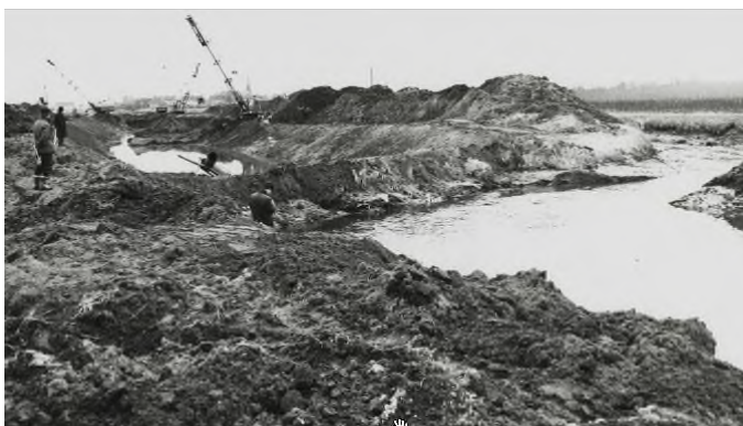
Afbeelding 7. De grondwerkzaamheden samenhangend met het rechtekken van de beekloop.
