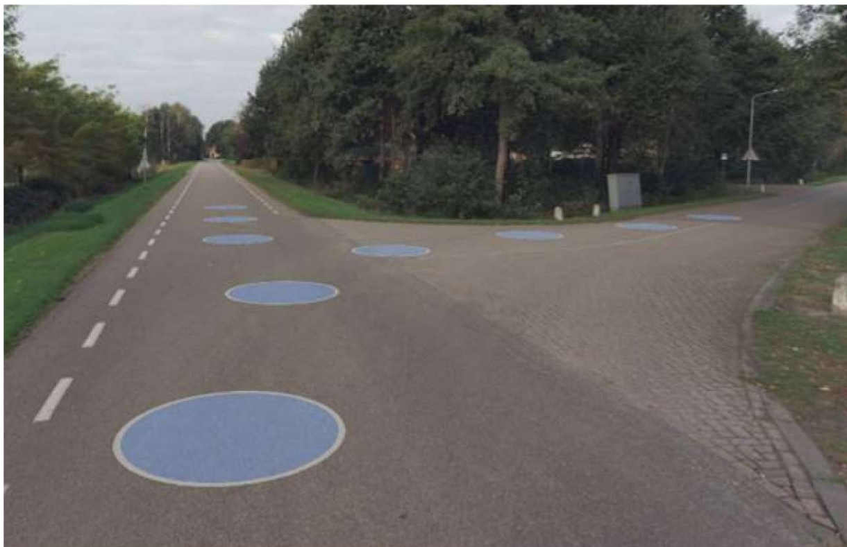
Afbeelding 1: Bestrating ter hoogte van aansluiting Hoefstraat – Pannenhoefsebaan.
