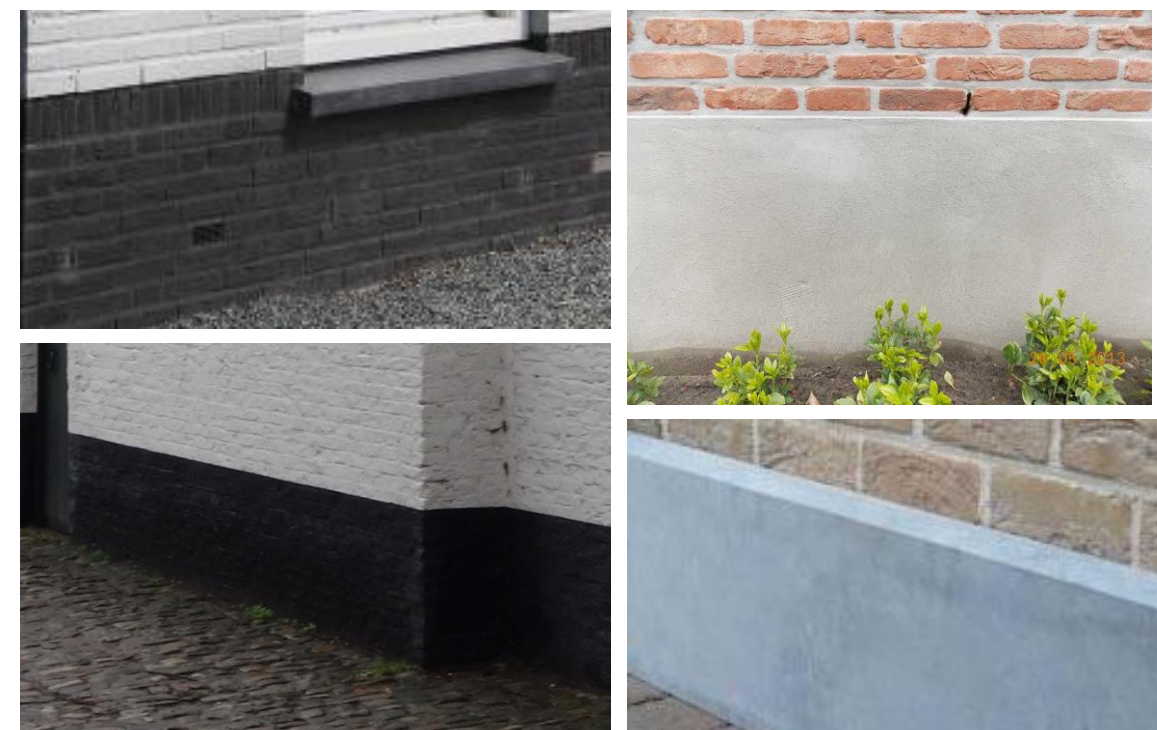
Referentie gemetselde, gecementeerde of hardstenen plint
