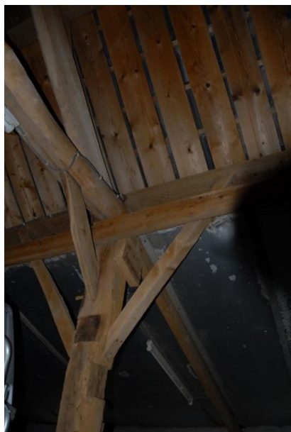
Zelfde detail gebint naar de zijbeuk toe gezien.
