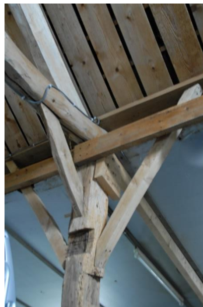
Detail gebint, inkepingen duiden op ander eerder gebruik.
