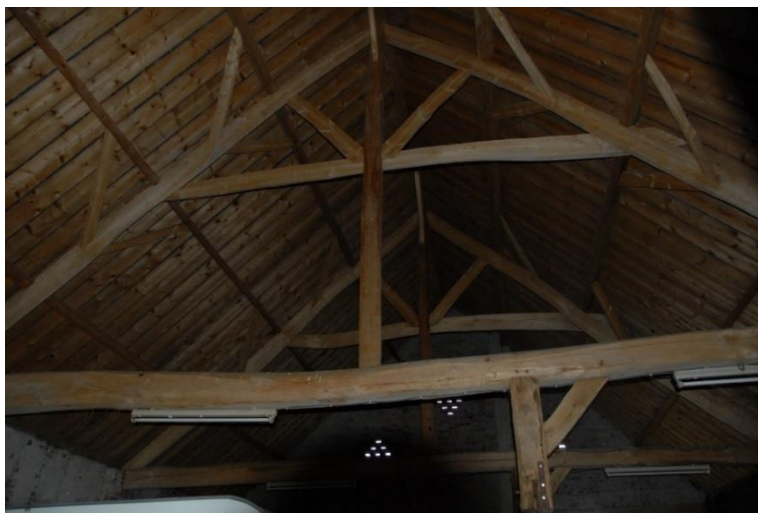
Interieur gordingenkap richting het oosten gezien.
