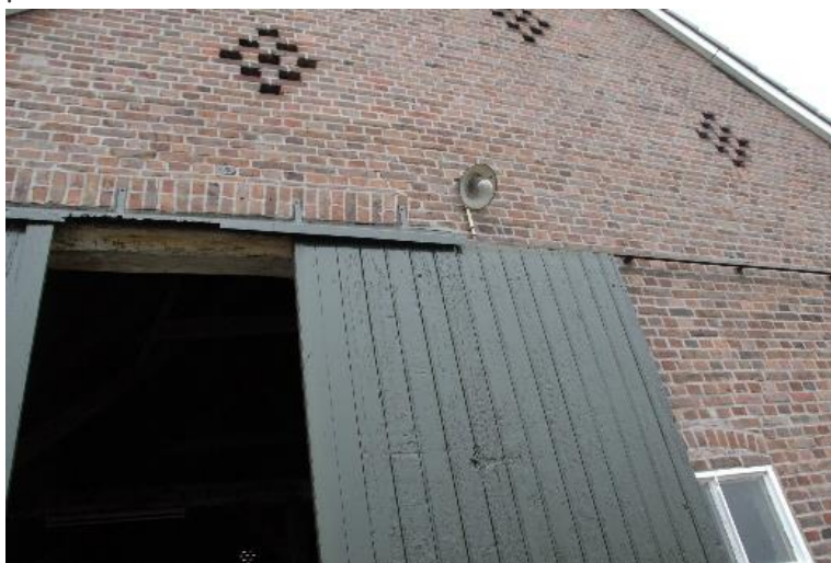
Achtergevel, detail deeldeuren op rails
