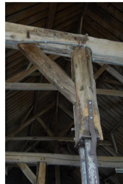
H-balk met gebintstijl verbonden door verbindingstuk
