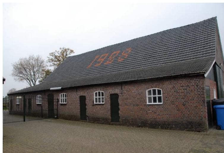
De rechterzijgevel vanuit de achterzijde gefotografeerd
