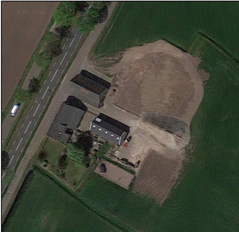
Afbeelding 4: Luchtfoto plangebied met gesaneerde stallen
