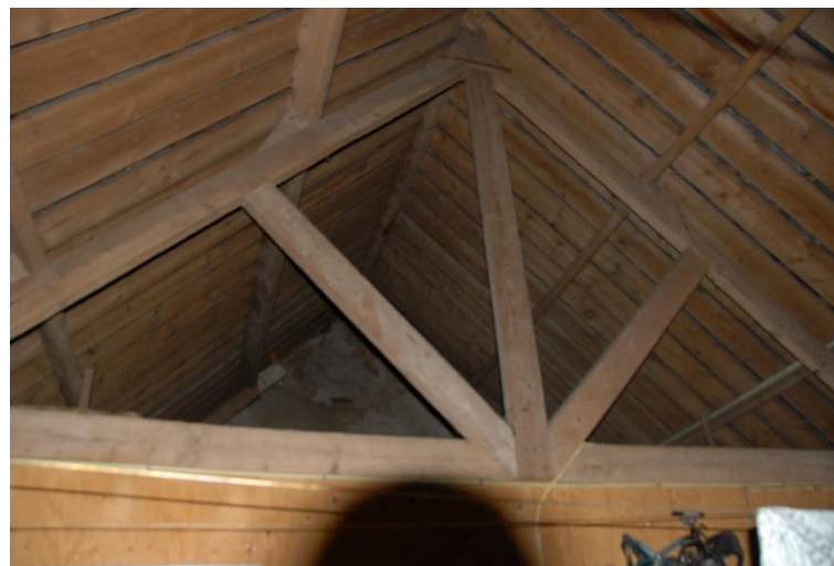
Eén van de verbeterde Hollandse spanten.
