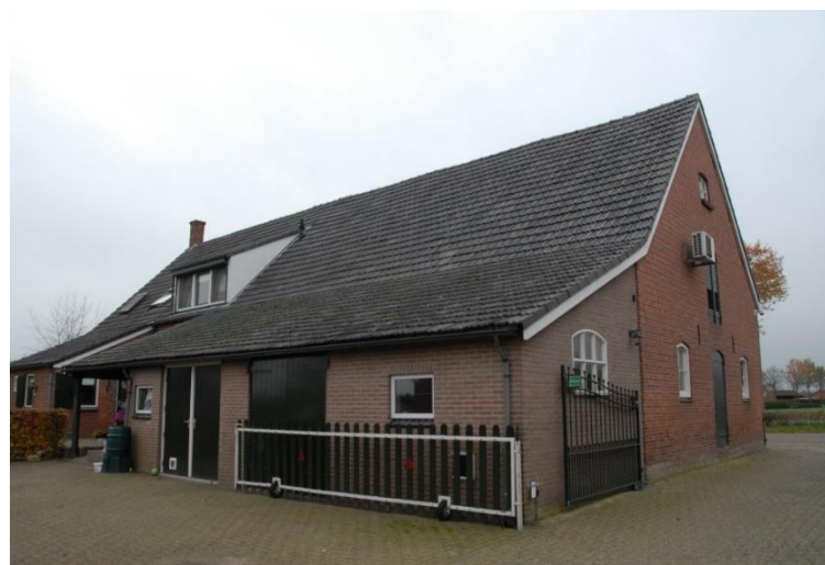
Achtergevel rechter zijbeuk, later aangebouwd.
