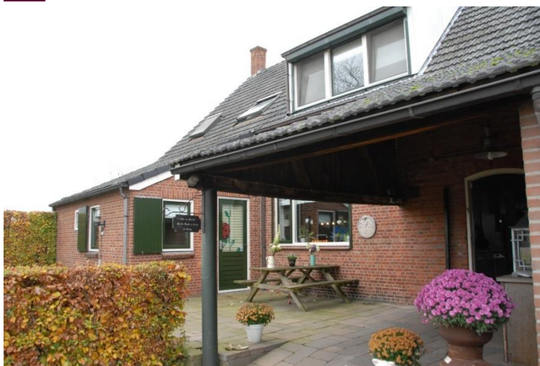
Achtergevel, overkapt plaatsje met ingangsdeur
