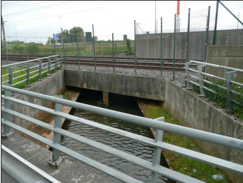
Figuur 4.4.3 Onderdoorgang grensloot onder parallelweg, spoor en A16.
