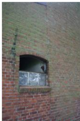
De deelnaad tussen de zijbeuk en de middenbeuk is in het metselwerk duidelijk zichtbaar.
