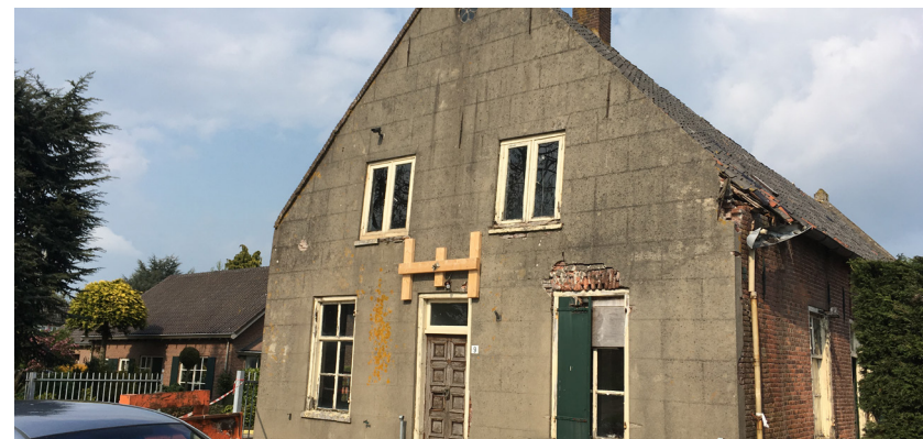
1. Bestaande boerderij. Wordt opgeknapt tot fraaie woonboerderij.
