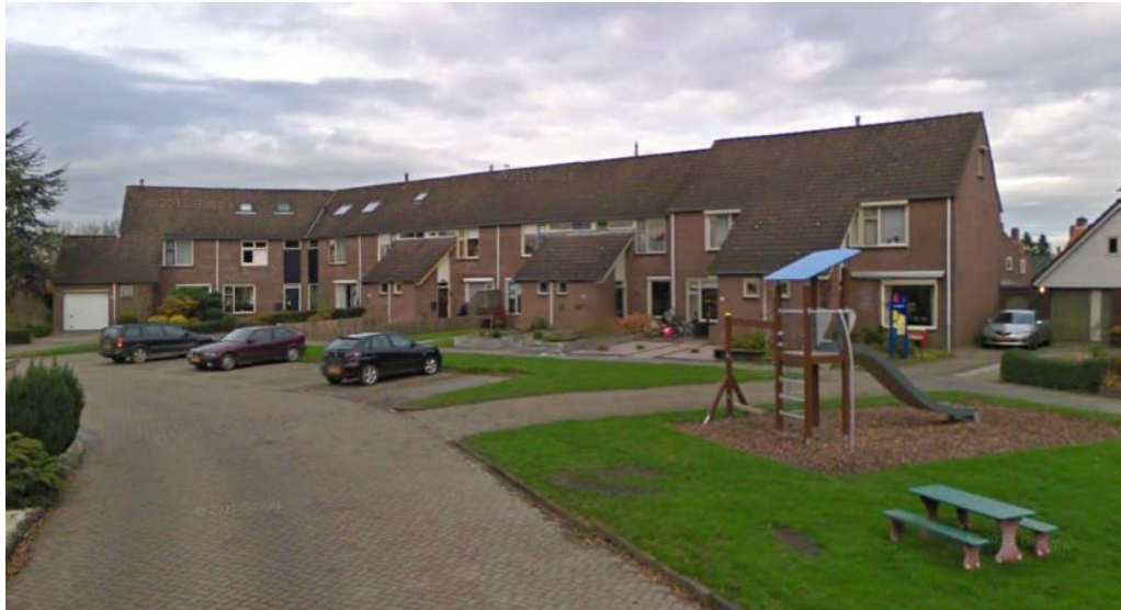
Afb. 12: Het vrij lange blok van rijwoningen aan De Geer met knik en verspringing in de gevel.
