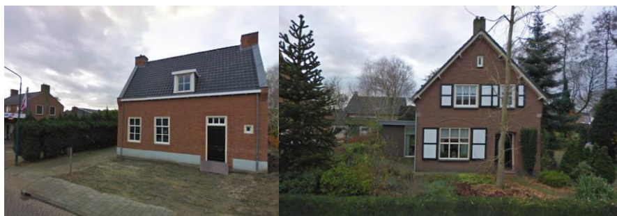
Afb. 11: De twee vrijstaande woningen ten noorden van het plangebied, de recent gebouwde woning grenzend aan het plangebied (links) en de woning met rijkere detaillering ten noorden daarvan (rechts).
