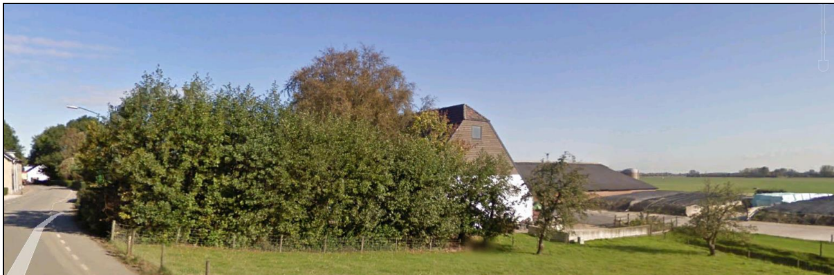
Afbeelding 14: Aanzicht zuidzijde (Bron: Google streetview)
