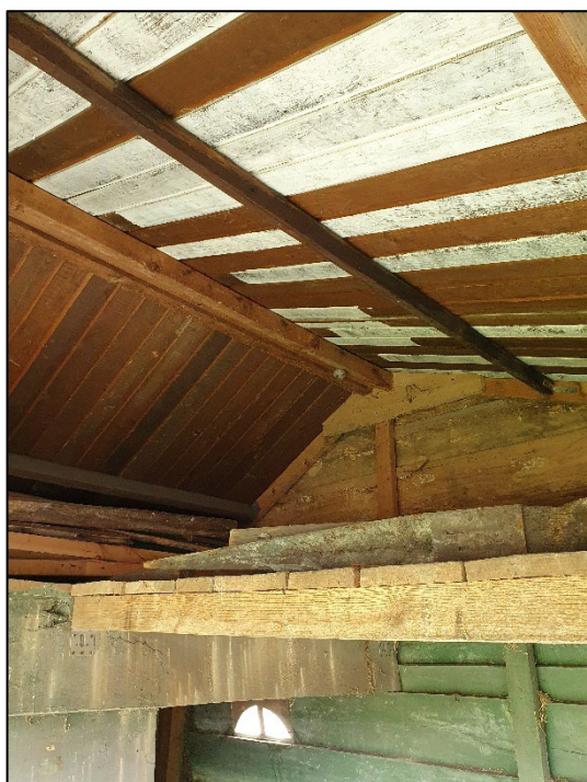
Figuur 6: Foto's van de daken zonder dakbeschot.
