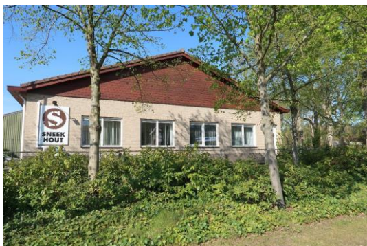
Kantoorgebouw vanaf Antwerpsestraat
