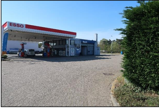
Tankstation met wasstraat
