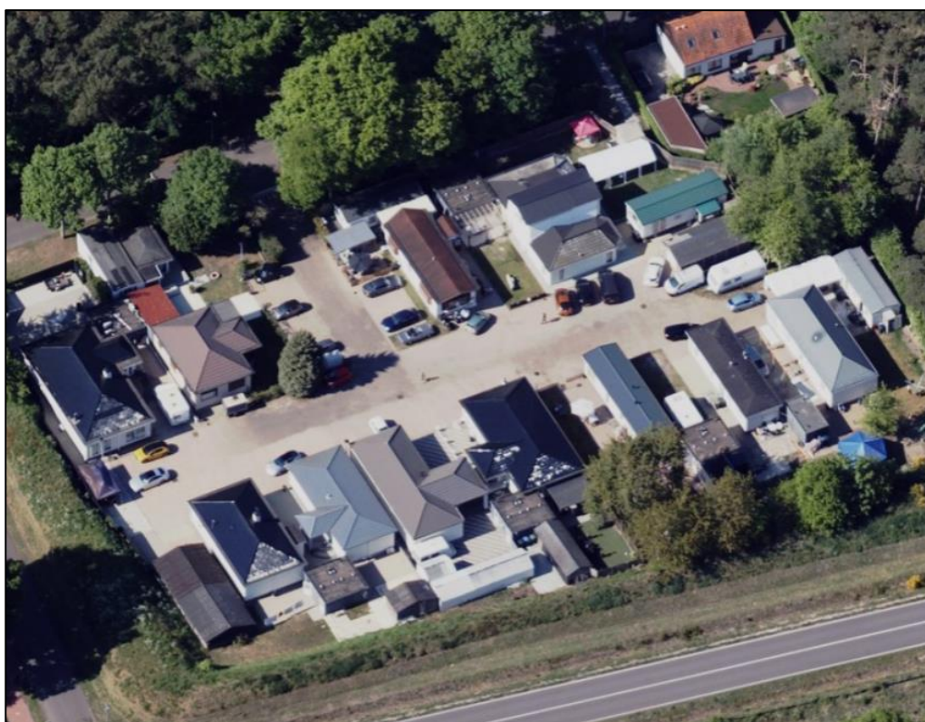
Plangebied gezien vanuit zuidelijke richting. Bron: Cyclomedia Technology B.V., 2021.
