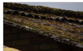
Foto 14: Golfplaten dak op schuur.
