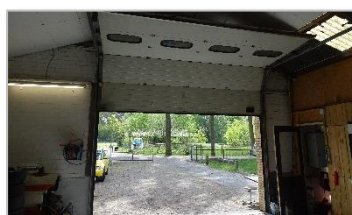
Foto 17: Schuur in gebruik als hobbygarage.
