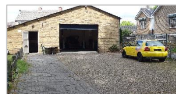
Foto 20: Verharding voor schuur.
