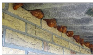
Foto 15: Afdichting met PUR-schuim tussen golfplaten dak en muur.
