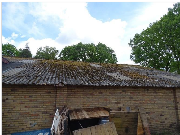
Foto 7: Impressie plangebied (dak schuur) Anjerstraat 29 te Putte.
