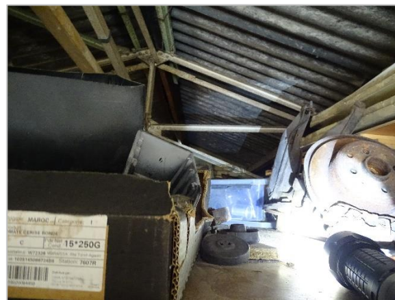
Foto 10: Impressie plangebied (zolderruimte boven garageboxen) Anjerstraat 29 te Putte.
