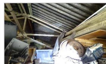
Foto 18: Opslag materiaal zolderdak boven garageboxen.
