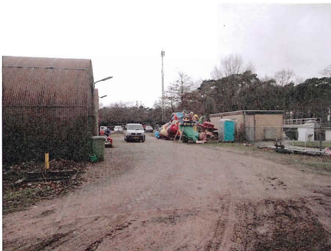
Foto 2: Klinkerverharding ten noorden van de romneyloodsen (gezien vanaf het oosten, 4 februari 2013)
