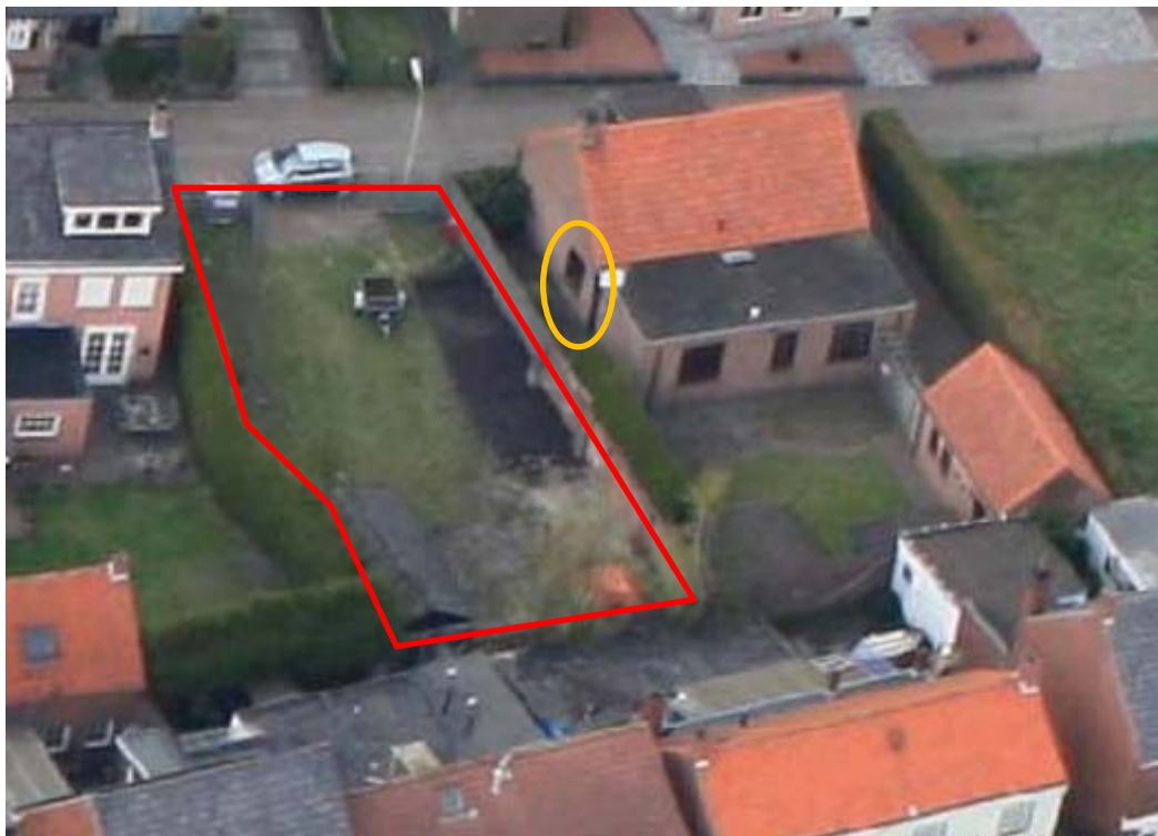
Vogelvlucht van de bouwlocatie (rood) en naastgelegen bebouwing met betreffende raampartijen (oranje)
